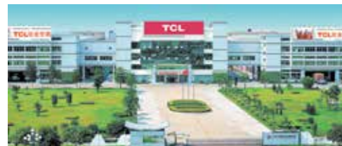
1 1-ый завод в г. Чжуншань (6 млн. единиц наружных блоков для кондиционеров)
